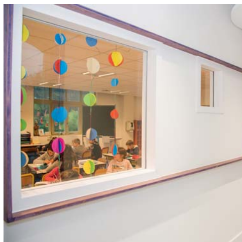
L'aile Sud du bâtiment de l'école César Terrier a accueilli les premiers élèves à la fin de l'automne.
