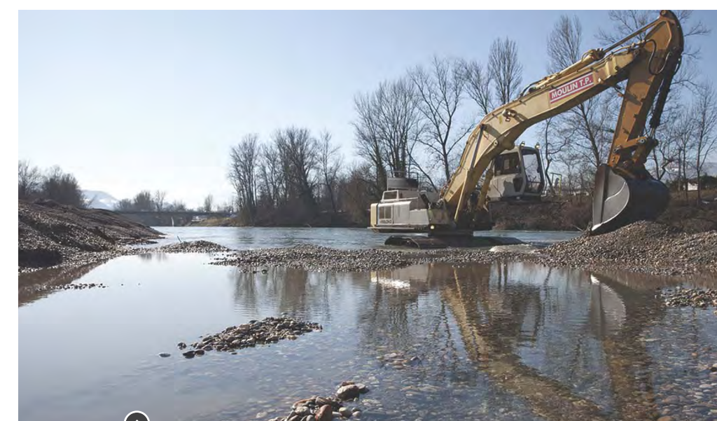
Des travaux dans le lit de l'Isère
