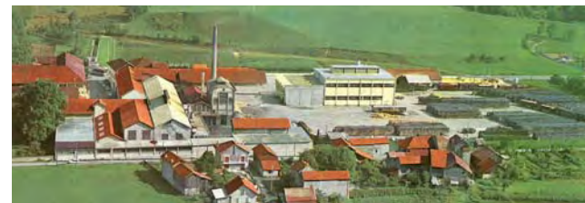
Les papeteries de Moulin-Vieux
