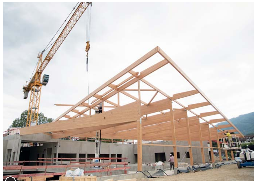
La charpente est maintenant posée.
