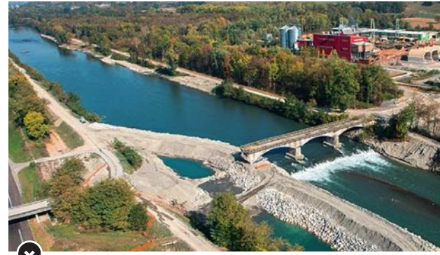
⌵ Pont de La Buisnière.
