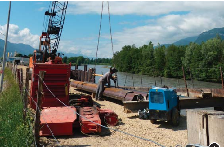
Travaux d’aménagement de la rive gauche de l’Isère pour conforter les berges
