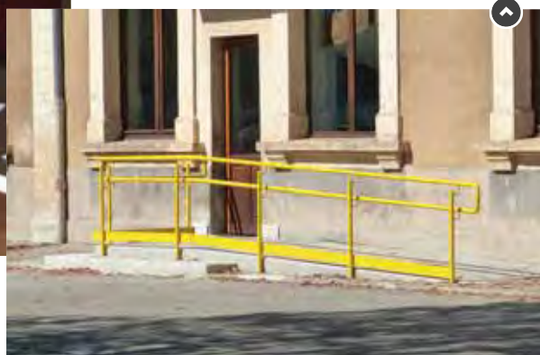
De nécessaires aménagements d'accessibilité, comme ici, à l'école César Terrier
