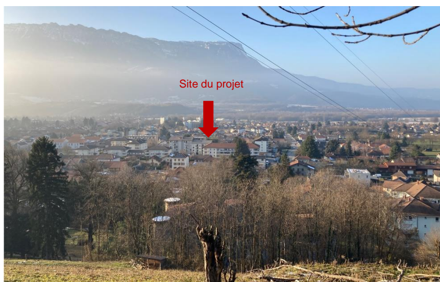
Vue sur Pontcharra depuis la RD 288 en direction de La Chapelle Blanche à l'occasion d'une trouée parmi les boisements. Le site reste peu visible.
