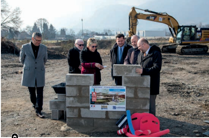
En janvier 2019, début des travaux de la piscine intercommunale, la deuxième sur le territoire après celle de Crolles.
