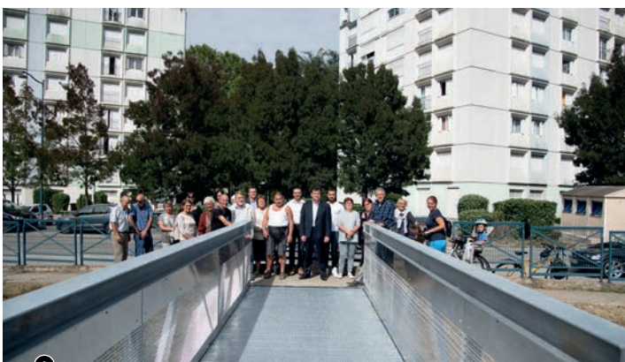
À l'automne 2019, la nouvelle passerelle piétons, cycles sur le Bréda est mise en service. Elle permet de traverser cet affluent de l'Isère au niveau du lycée et de la Résidence Bayard.
